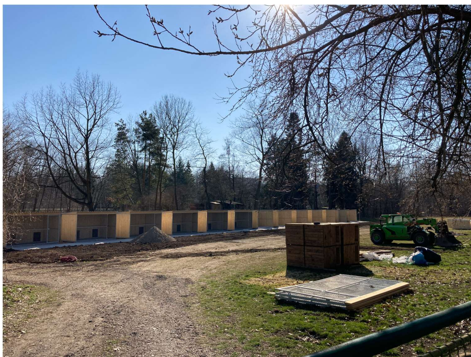
obr.: stávající stav oploceného areálu psího útulku, přes jehož území je trasován LBK č. 16a
